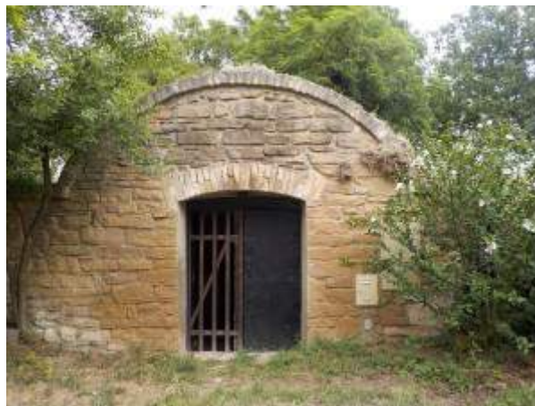
Une cave ou un endroit enterré ou ombragé pour les poissons d'eaux fraîches
