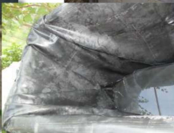
On en a bavé pour placer la bâche avec le moins de plis possibles!
